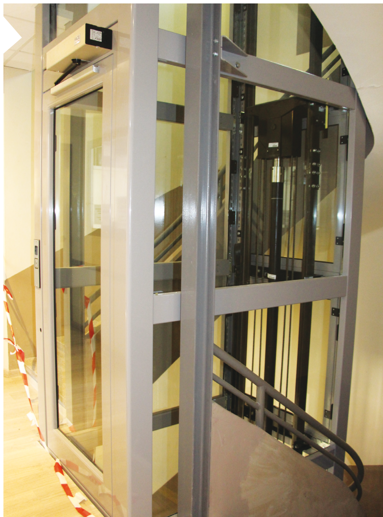
POSE D'UN ASCENSEUR DANS L'AILE B DE L'HÔTEL DE VILLE.
