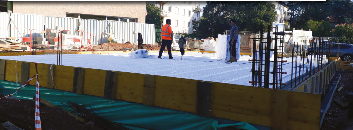
AGRANDISSEMENT EN COURS DE L'ÉCOLE MATERNELLE. PRISE DE VUE EFFECTUÉE EN SEPTEMBRE 2020.
