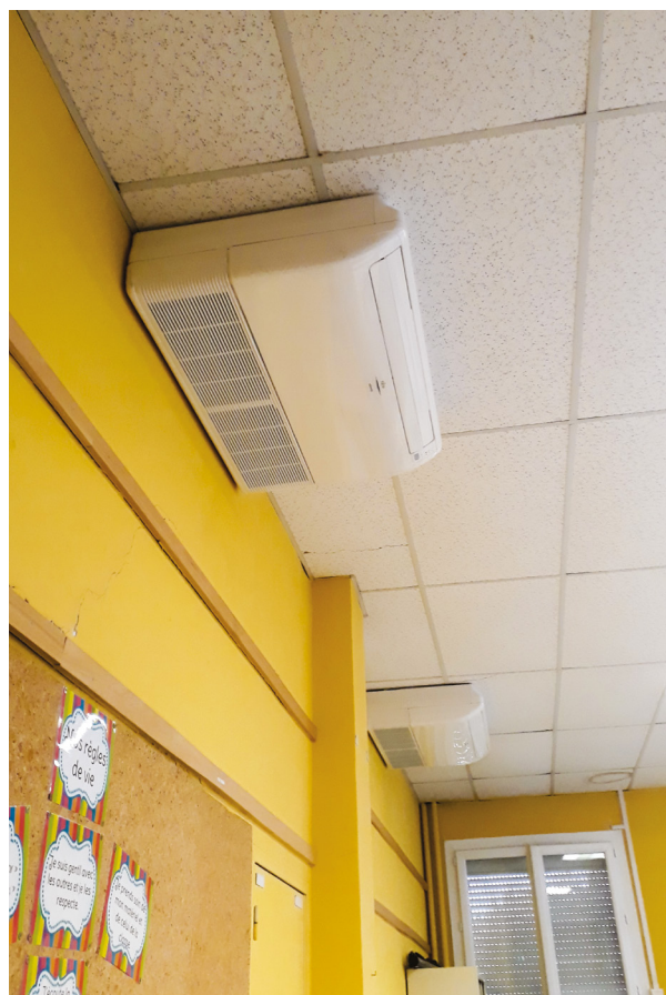
INSTALLATION DES POMPES À CHALEUR AU SEIN DE L'ÉCOLE ÉLÉMENTAIRE DENIS TISSOT.
