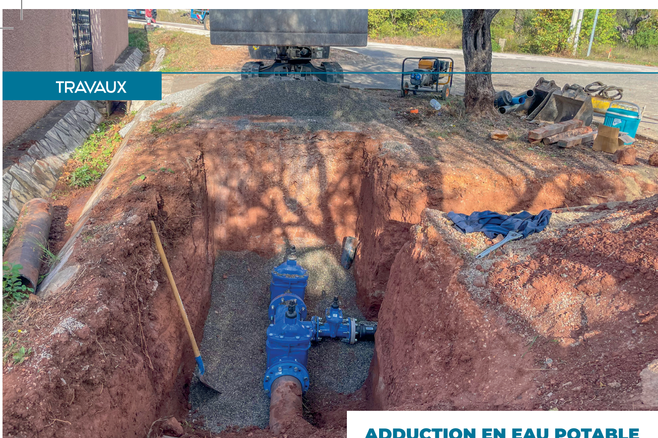
TRAVAUX SUR LES RÉSEAUX D'EAU DU CHEMIN DU CHÂTEAU, OCTOBRE 2022.
