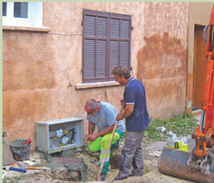
Réparation d'une fuite
