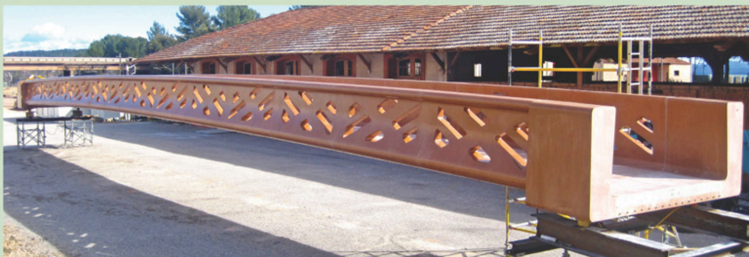
Vernissage de la passerelle et préparation aux tests de conformité
