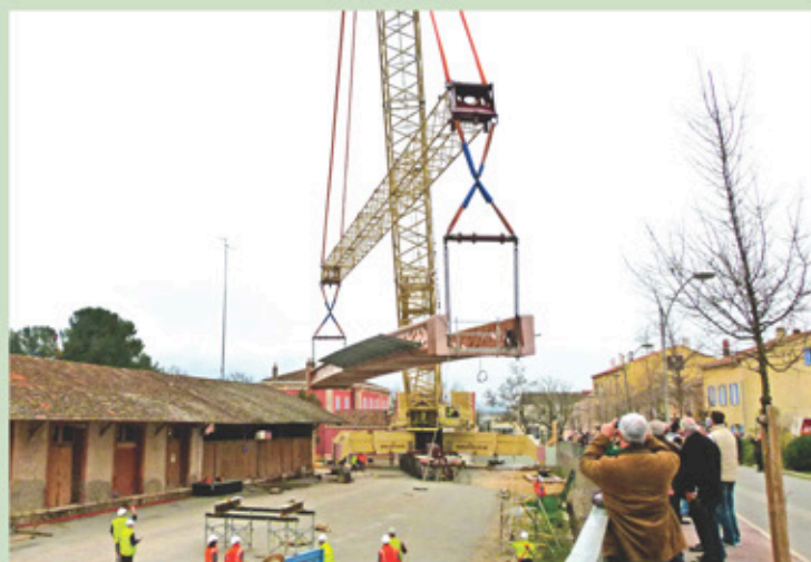
Mise en place de la passerelle
