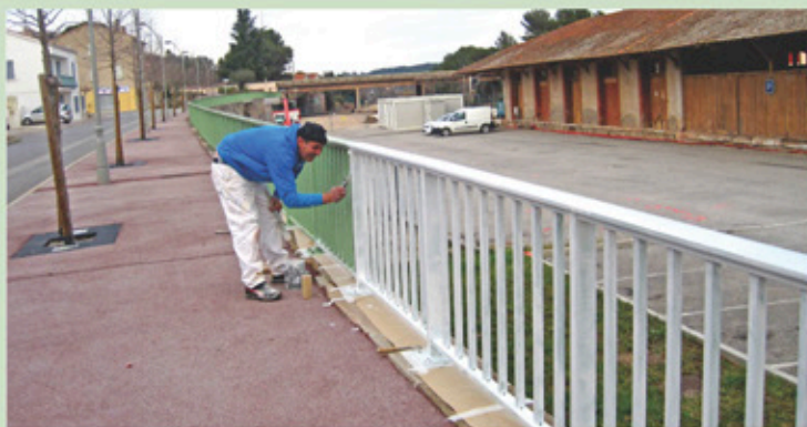
Réfection des peintures de la barrière de l'avenue du 8 mai 1945
