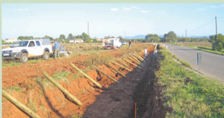
Aménagement de la rive du ruisseau de St-Andrieux (en cours)
