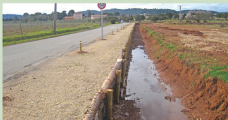
Aménagement de la rive du ruisseau de St-Andrieux (terminé)
