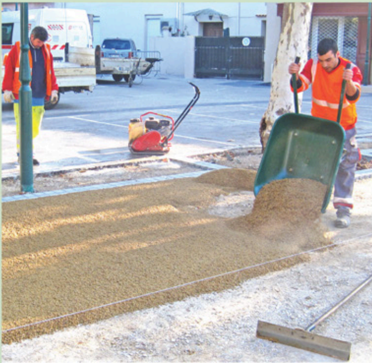
Travaux en cours
