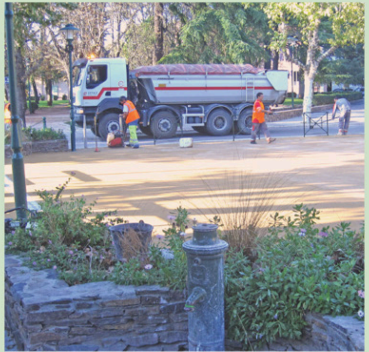
Travaux en cours
