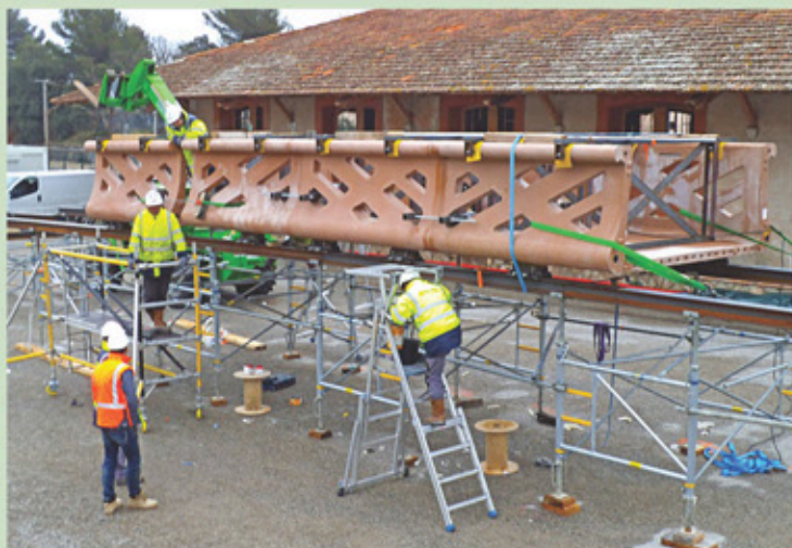
Assemblage des éléments voussoirs préfabriqués en usine
