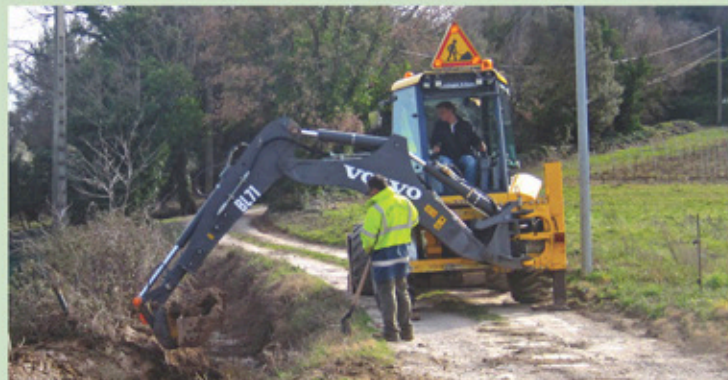
Travaux de curage et reprise d'un fossé
