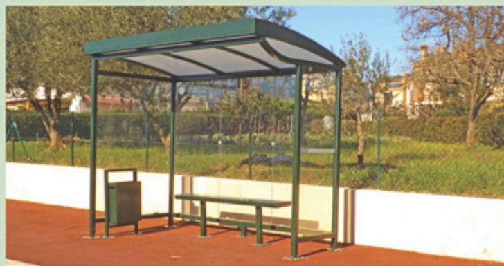
Abri bus du Chemin du Bouillidou
